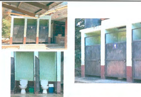
Foto 4: Mejoramiento e instalación de puertas y sanitarios.
